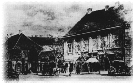
2. ábra Belezna-kert Kerepesi útra néző épületei 22
