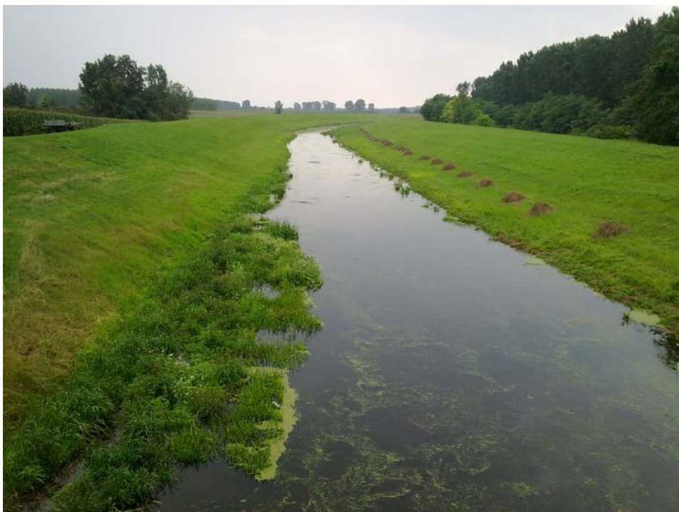
II. függelék: Lónyai-főcsatorna (Tiszabercel)
