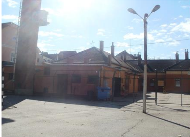
7. kép. A kazánház (saját fotó)
