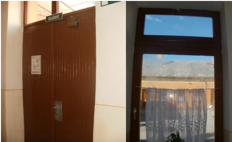
3-4. kép. Az általános iskola nyílászárói (saját fotó)
