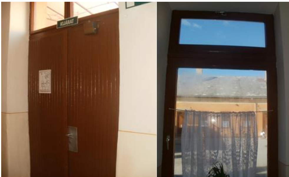
3-4. kép. Az általános iskola nyílászárói (saját fotó)
