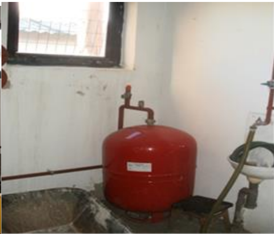
16. kép. A tágulási tartály (saját fotó)
