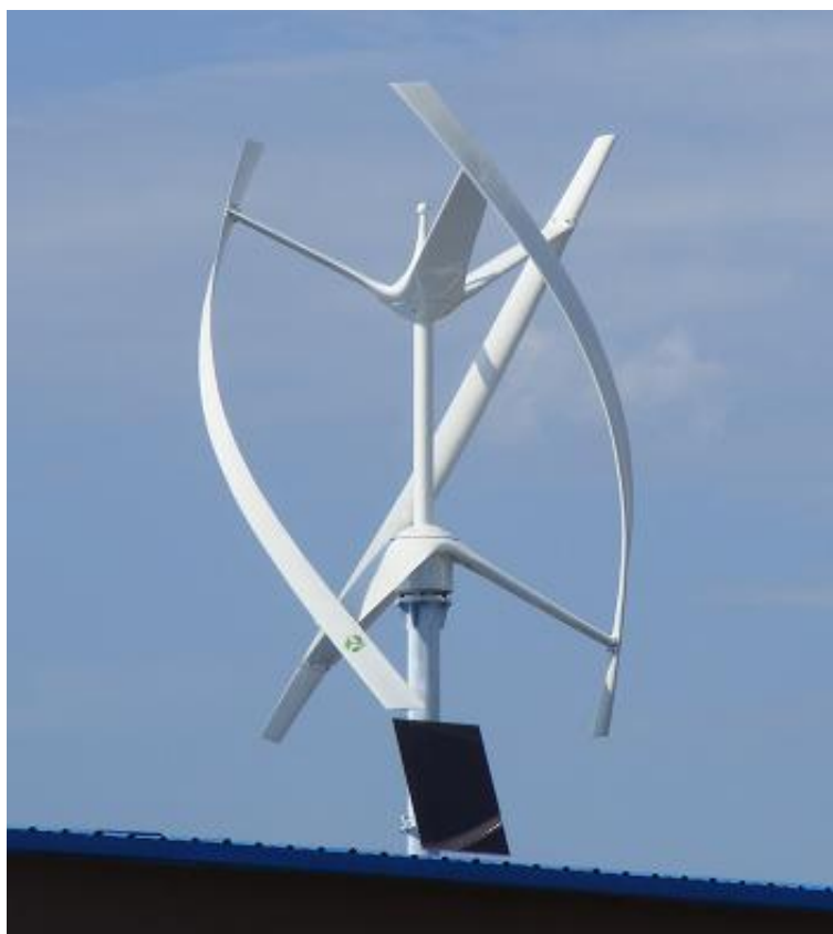
2.3 ábra: Spirális Darrieus rotor [5]
