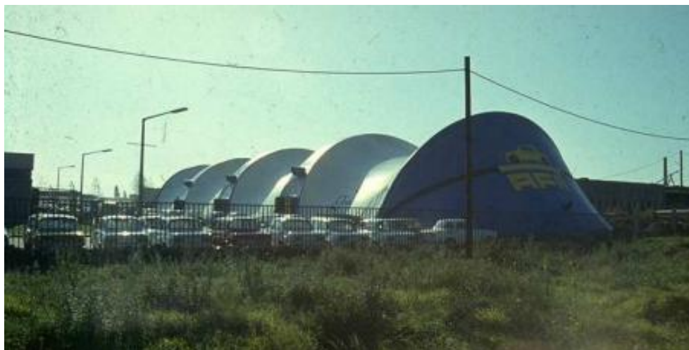
2. ábra A győri AFIT sátor ponyvaszerkezete [6]
