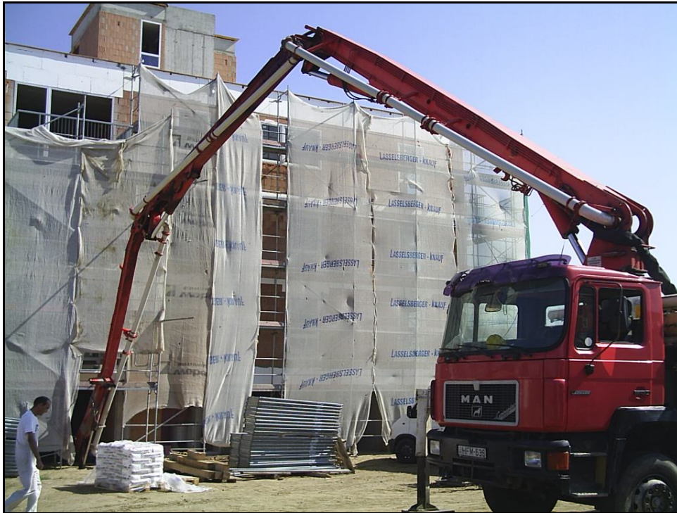
3. ábra: Betonszivattyúhoz csatlakozó csővezeték
