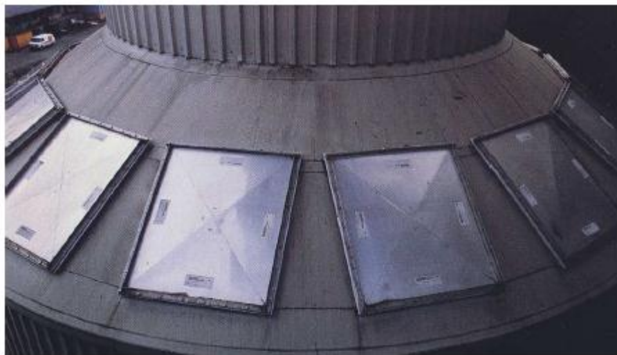
1-2. ábra Cukortároló védelme hasadó panelekkel
