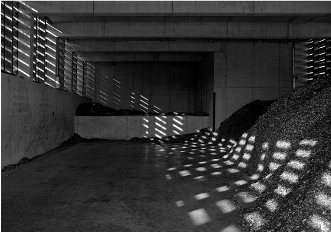
/10.kép/ Pannonhalma , Biomassza Fűtőmű
