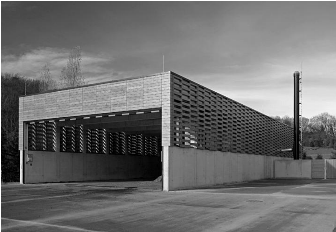
/11.kép/ Pannonhalma , Biomassza Fűtőmű
