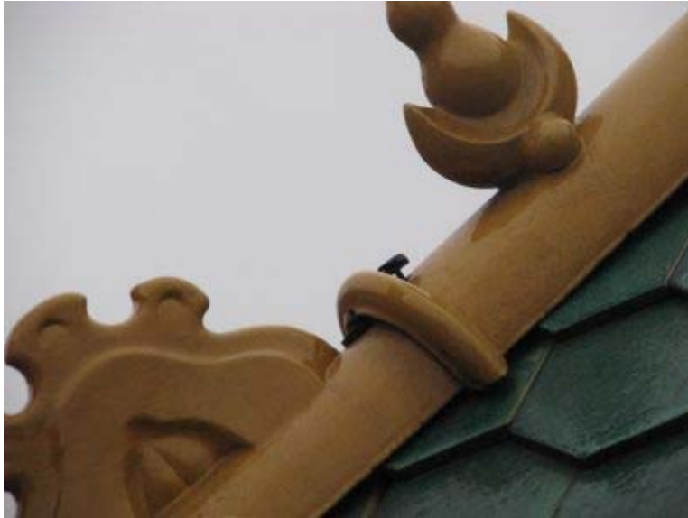
3.2. kép: Kúpcserép rögzítése szöggel
