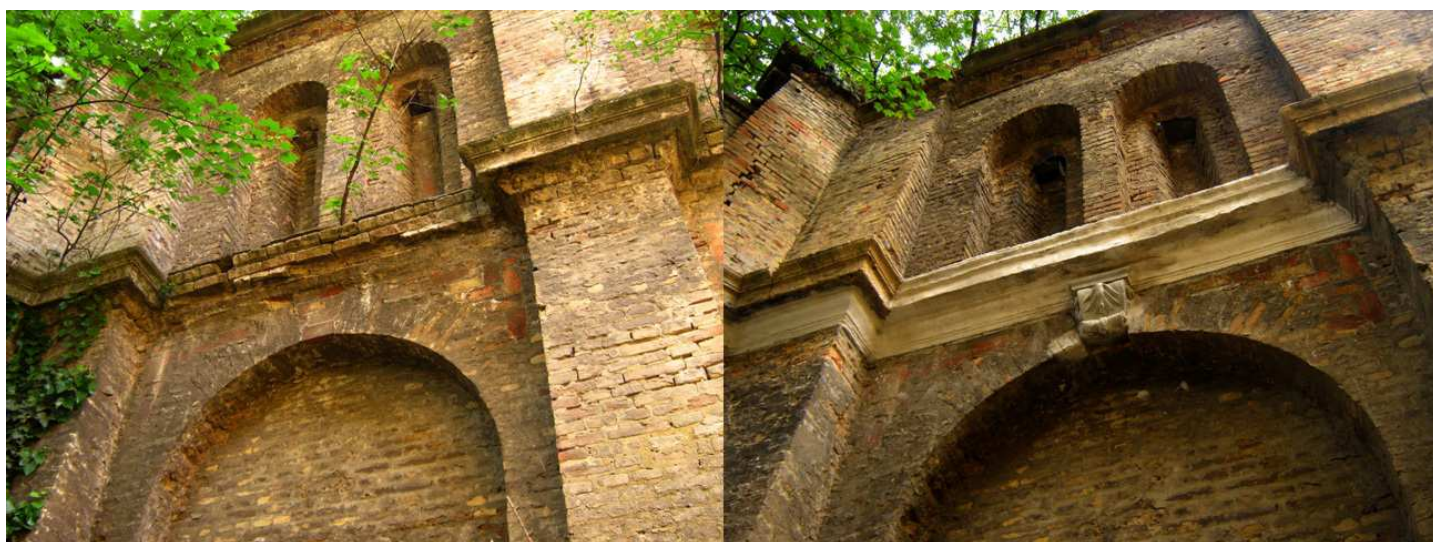
127. ábra A támfal hiányzó párkányainak pótlása, kiegészítése
