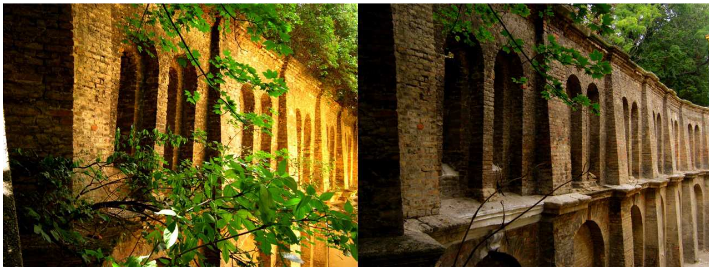
130. ábra Bántó gyökérzetű növényzet felszámolása, támfal megtisztítása
