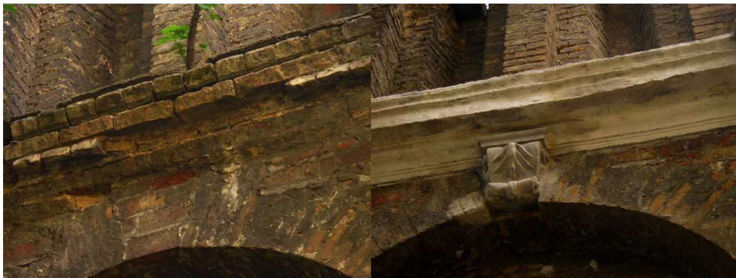
128. ábra Új, beton zárókő és húzott párkány az eredeti helyére
