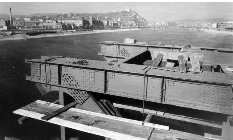
8. Az újjáépülő Petőfi híd, 1950.
