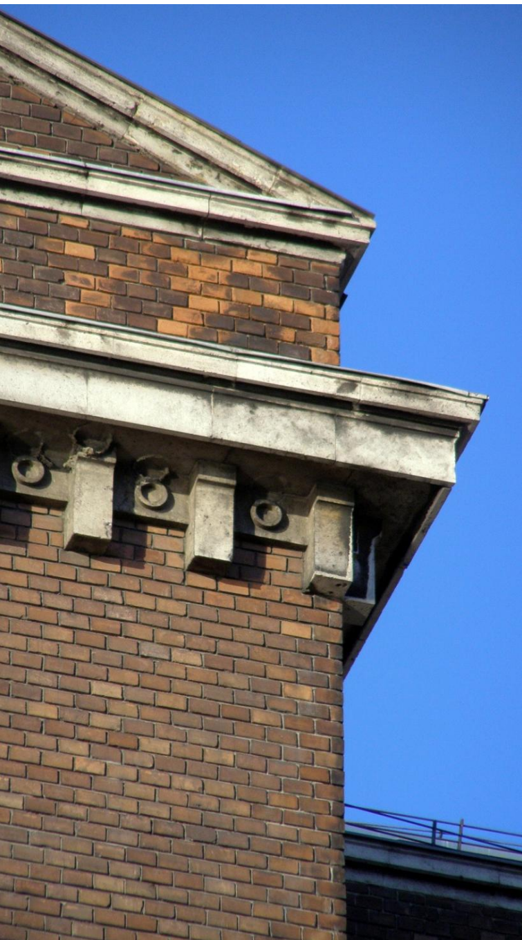
46 Bejárati rizalit részlete
