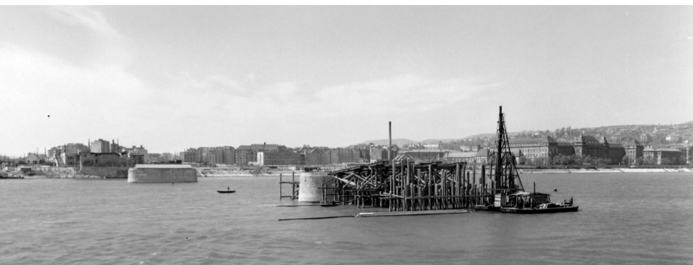
9. Az újjáépülő Petőfi híd, háttérben a Műegyetem épületei
