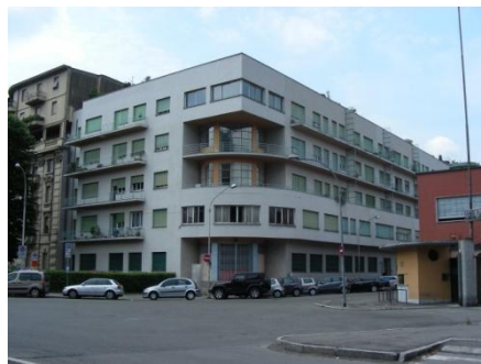
Terragni: Novocomum, Como
