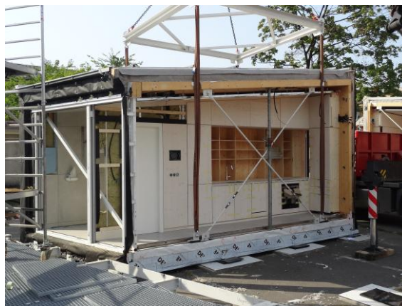
15. ábra: A berendezett ház merevítésekkkel
