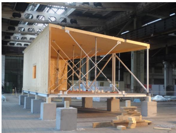
14. ábra: A szerkezet ideiglenes merevítésekkkel
