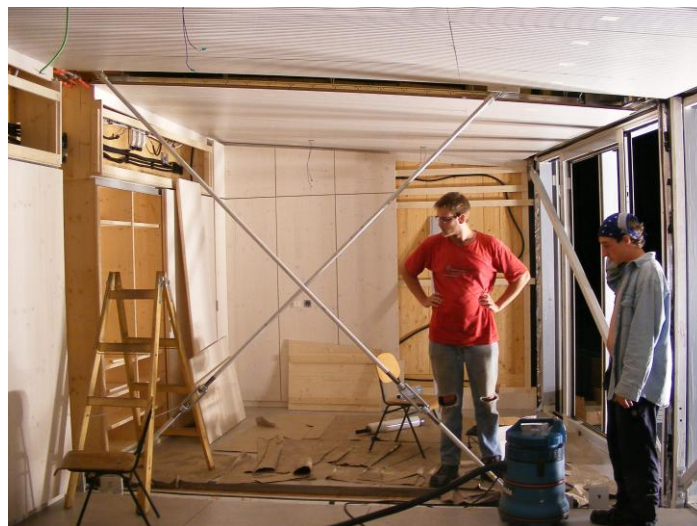
20. ábra: Szerelősáv a modulok toldásánál
