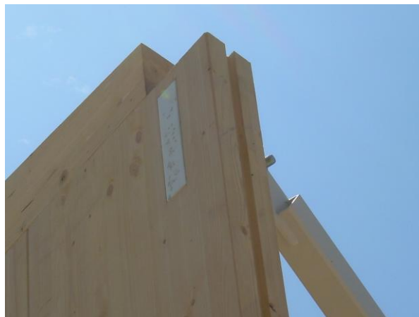
18. ábra: Az elkészült acél hátlap a falhoz való csatlakozáskor
