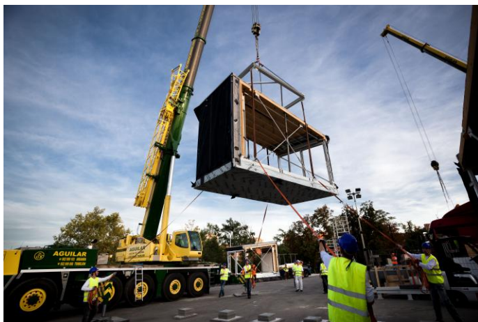
31. ábra: A „B” modul emelése
