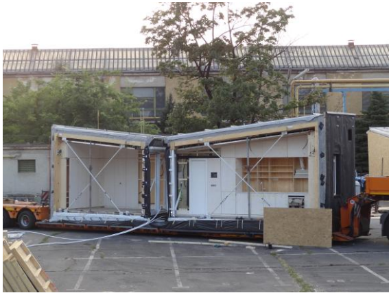
48. ábra: Az "A" és a "D" modul a kamionon elhelyezve
