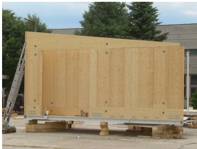
25. ábra: A rétegelt-ragasztott fal a gyűrűkkel
