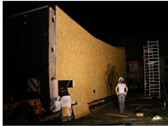
49. ábra: OSB táblák rögzítése a modulokra
