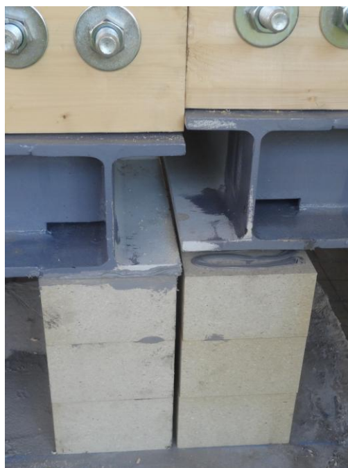
40. ábra: Purenit tömbök az alapozás és a padlószerkezet között a „C” modul helyezésekor éppen a felragasztás előtt
