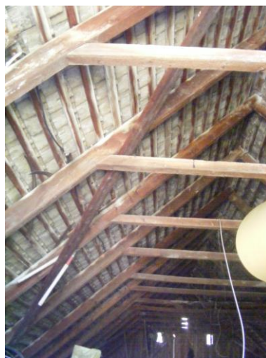
Nedves tetőszervezet (73. kép)
