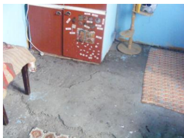
Látható aljzatbeton (63. kép)
