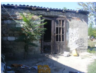
V6-os ház melléképülete (48. kép)
