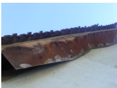
Penészes, mállott ereszdeszkázat (77. kép)
