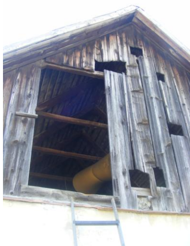
Hiányos oromfal-deszkázat (72. kép)
