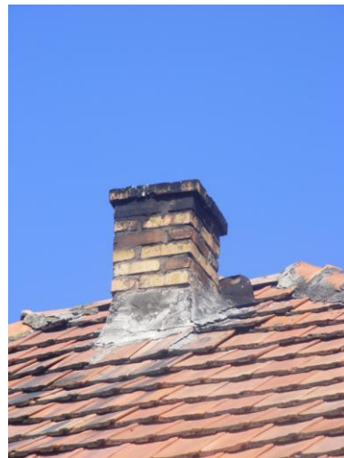
Új kémény- helytelen használat miatti állapota (76. kép)
