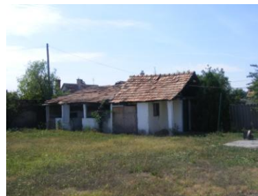
V3-as ház melléképületei (46. kép)
