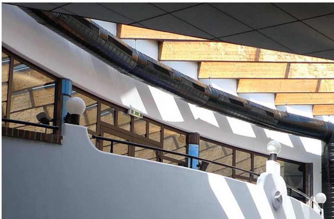
3.2. ábra, légcsatorna légrácsokkal, Bad Blumau, Ausztria, a szerző felvétele, azonos ellenállású kiömlőnyílások esete
