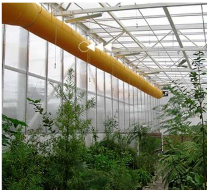
1.6. ábra: Áteresztő anyagú szövet légcsatorna, Prihoda.
