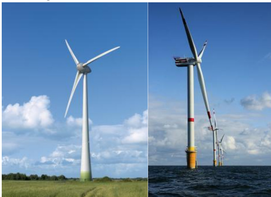
Balra: Enercon E-126, a világ legnagyobb szélturbinája. Teljesítménye 7,5 MW, legnagyobb magassága közel 200 méter, tehát kétszer magasabb a Parlamentnél. Jobbra: 5 MW-os tengeri szélturbinák az Északi-tengeren, Belgium partjainál
