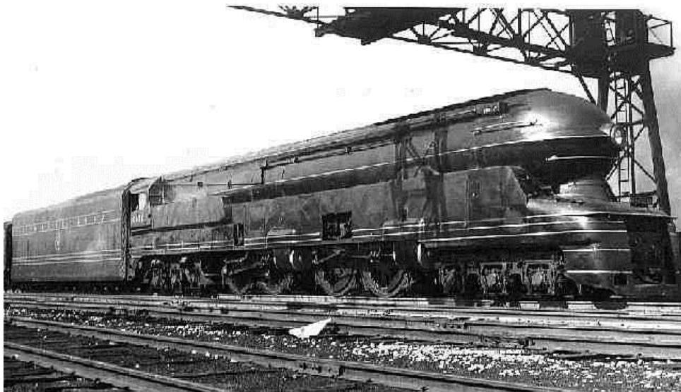
6-4-4-6 S1 duplex (két gőzgépes, merev) gőzmozdony. A kevés hajtott tengely miatt túl kicsit volt a tapadási tömege, ezért a kerekei menet közben folyamatosan kipörögtek. Az amúgy nagyon szép mozdony ezért bukásnak bizonyult, mert gyakorlatilag szétverte maga alatt a pályát.
