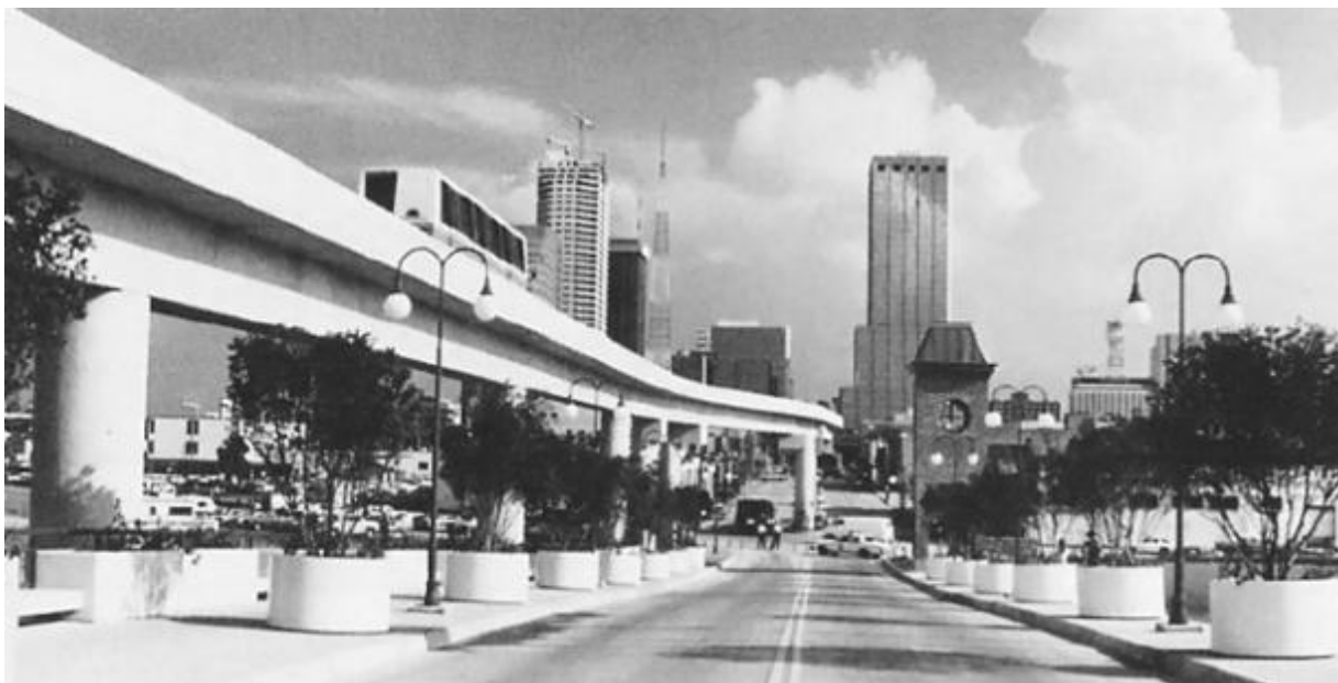
A Duke Egyetemen 2009-ig működő légpárnás személyszállító (balra fent), a los angeles-i Getty szanatórium szállítóeszköze (jobbra fent) és a Tampa városában 1999-ig üzemelő drótkötél-vontatású, légpárna-lebegtetésű Harbour Island People Mover (lent)
