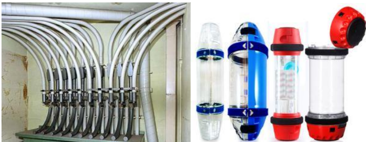
Balra: Egy pneumatikus csőposta fogadóállomása Jobbra: különböző, csőpostáknál használt kapszulák
