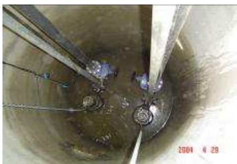
18. ábra: Átemelő szivattyúk komplett kivitelezése
