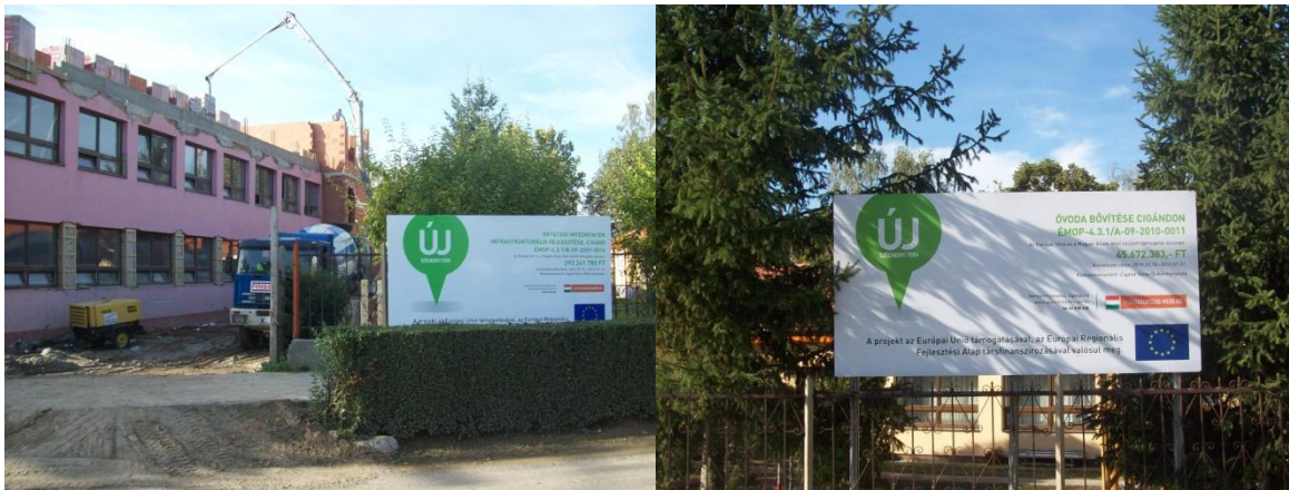
33. ábra: Iskolaépítés, Óvodabővítés
