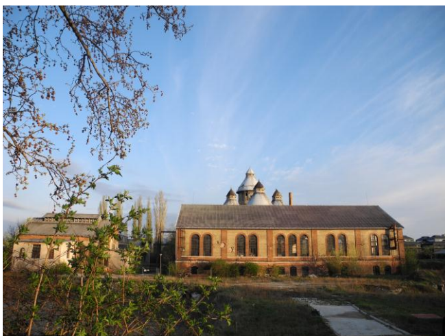
5. ábra Óra- és nyomásszabályzó berendezés csarnoka
