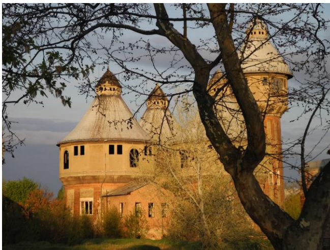
4. ábra Toronycsoport (víz, kátrány és ammóniavíz tartályok)
