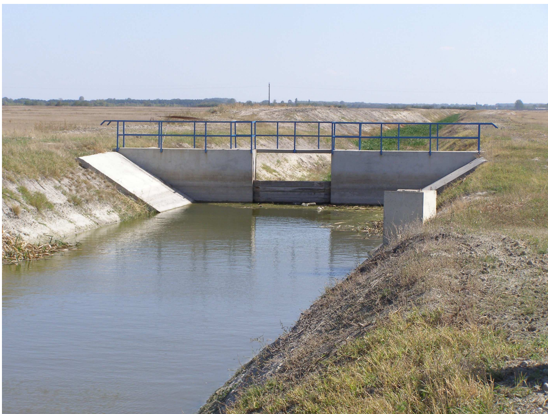
5. ábra a Körös-éri főcsatorna az 5+850-es km szelvényben (egy betétpallós műtárgy)
