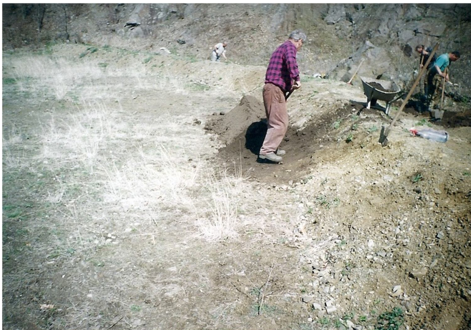
8.ábra: humusréteg terítése (saját kép)
