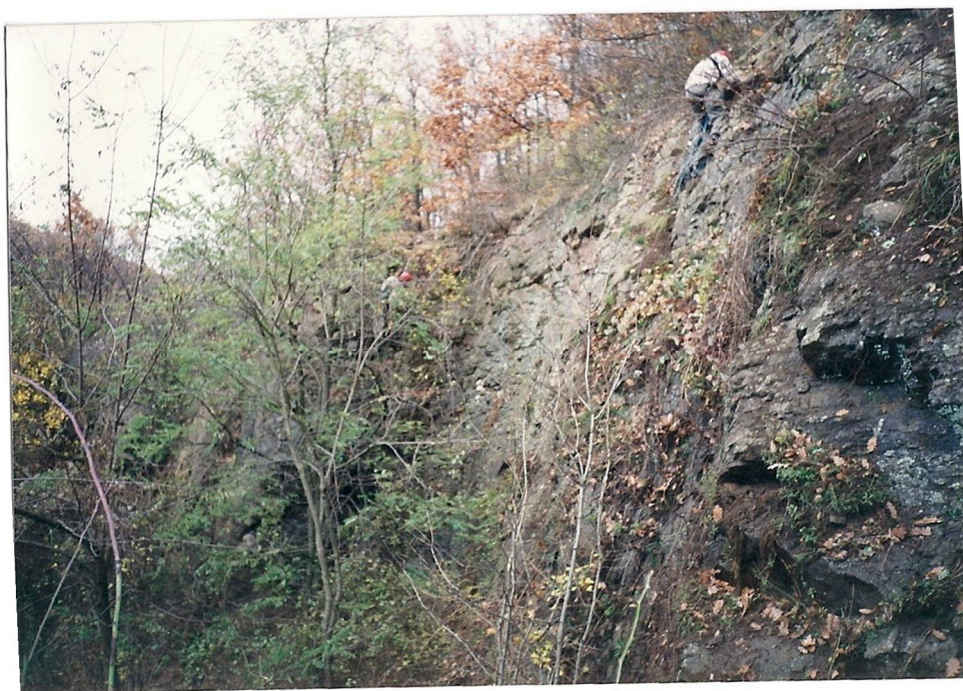
2. ábra: sziklafal kézi jövesztése bányász-alpin technológiával (saját kép)
