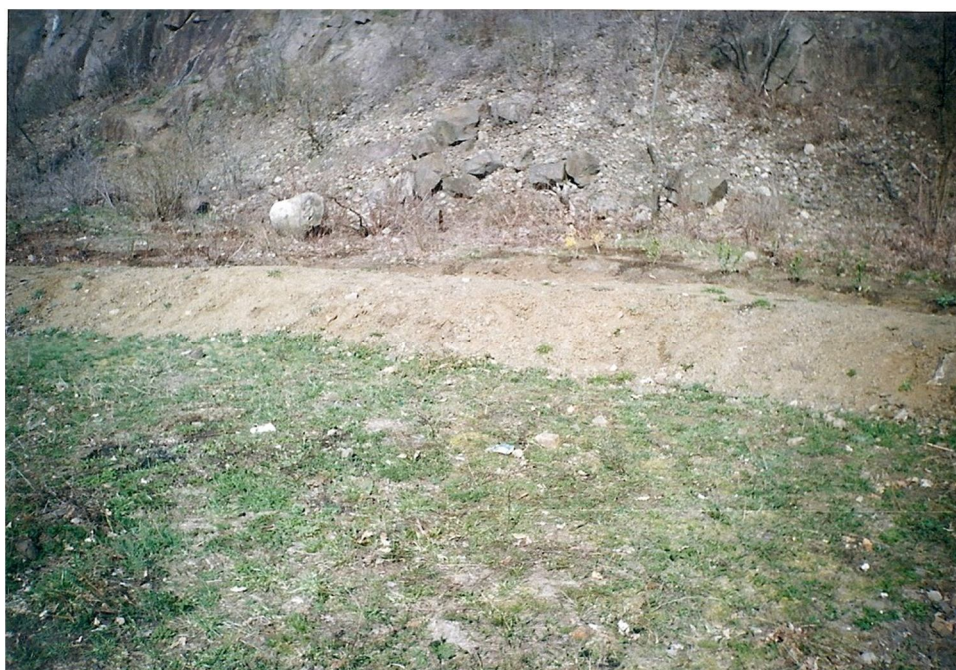
4. ábra: Belső bányaudvar védőgátas megvédése (saját kép)
