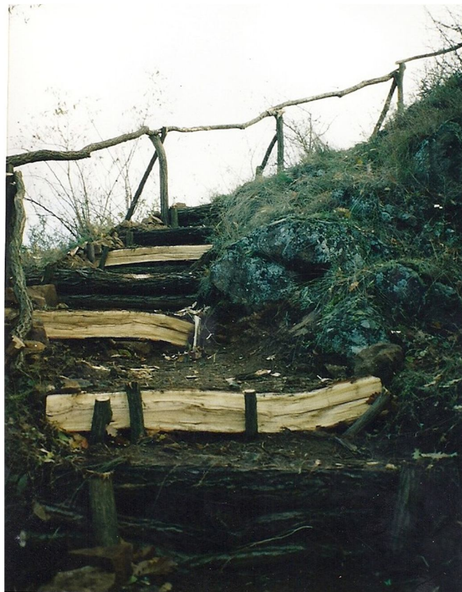
10. ábra: tereplépcsők, korlátok kiépítése (saját kép)
