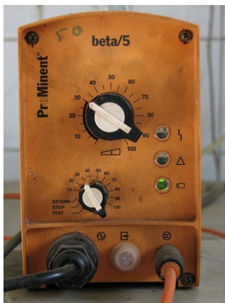
9. kép: Foszforeltávolítás vegyszeradagolójának szabályozó egysége (2012.11.09)
