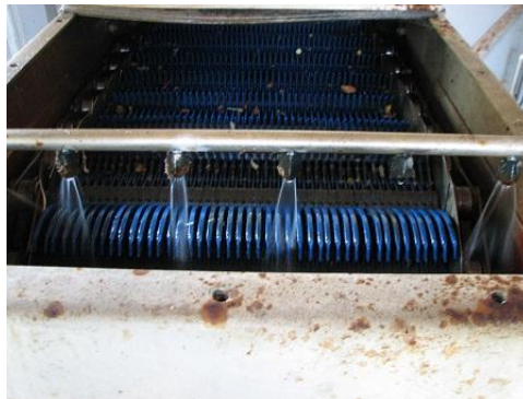
1. kép: Rácsszűrő a Solymári Szennyvíztisztító Telepen (2012. 09.16.)
