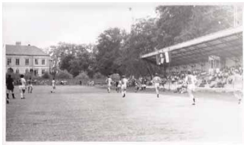
26. fotó: az erőműépítés alatt épült stadion (Bodó Tibor)
