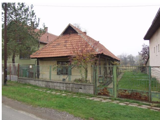
1. ábra „A” épület
