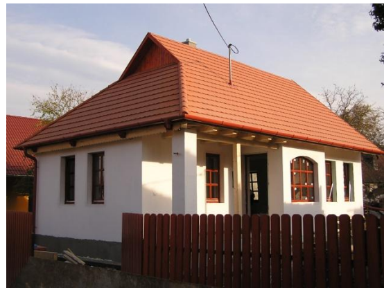
4. ábra „A” épület
