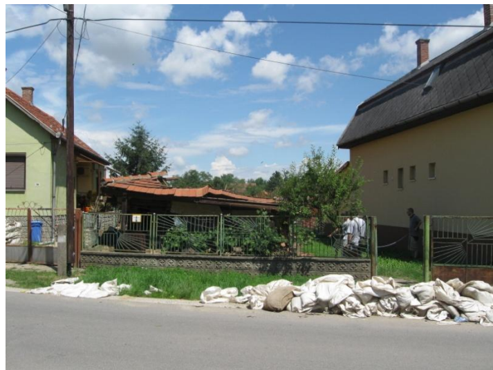
6. ábra „A” épület az árvíz után
