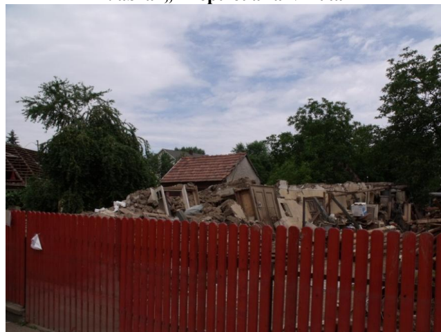
7. ábra „B” épület az árvíz után
