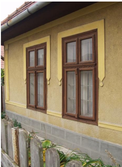
5. ábra „B” épület homlokzata
