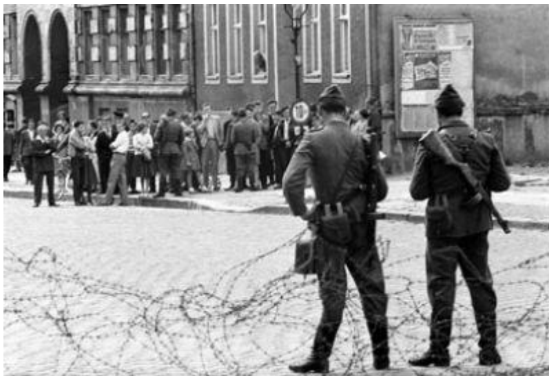
12. ábra. 1961. augusztus 13-a, reggel: meglepett kelet-berlini polgárok vizsgálgatják az éjszaka felállított szögesdrót-akadályokat, s az őket sakkban tartó határőröket.
