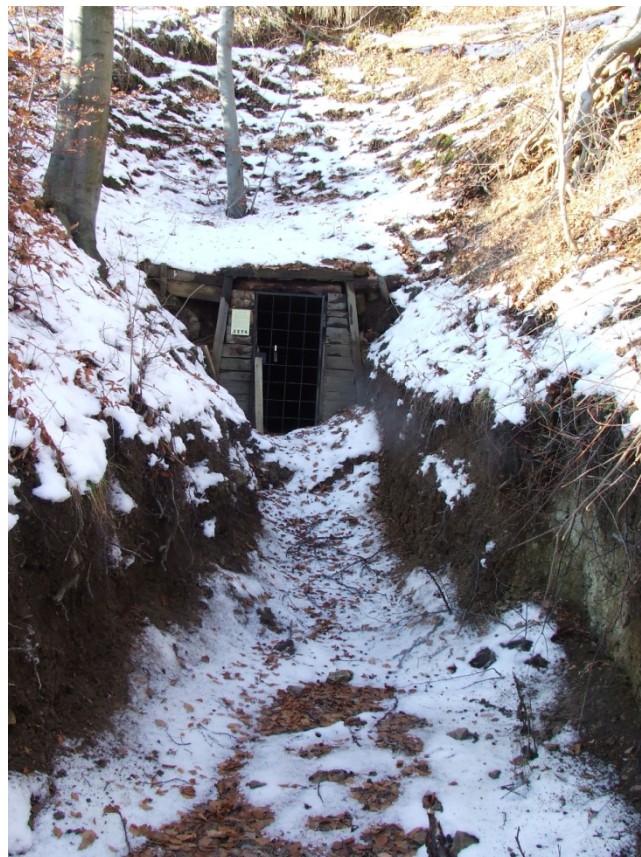
23. Kép: Teréz táró jelenlegi állapota
