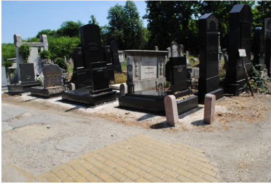
9. ábra: 1. - 2. konfliktus. A burkolatok töredeztettek, a szegély szinte mindenhol hiányzik. Több helyen nem következetes a burkolat kialakítása. (forrás: szerző)
