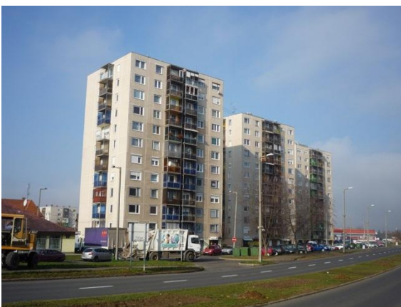
9. ábra: Paneles beépítése a '80-as évekből
