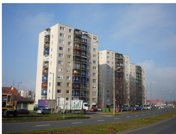
9. ábra: Paneles beépítése a '80-as évekből
