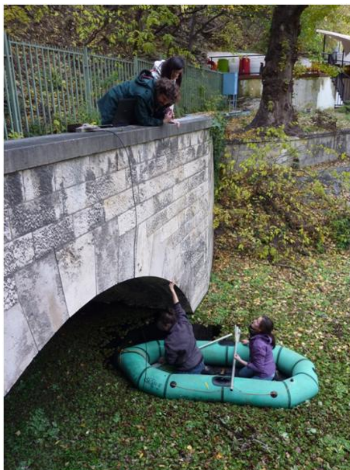
26. ábra: A Dataqua műszer elhelyezése a Boltív-forrás hasadékába (fotó: Csordás J.).
