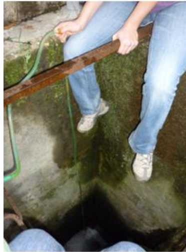
23. ábra: Jelzőanyag eresztése a csatornába (fotó: Csordás J.).
