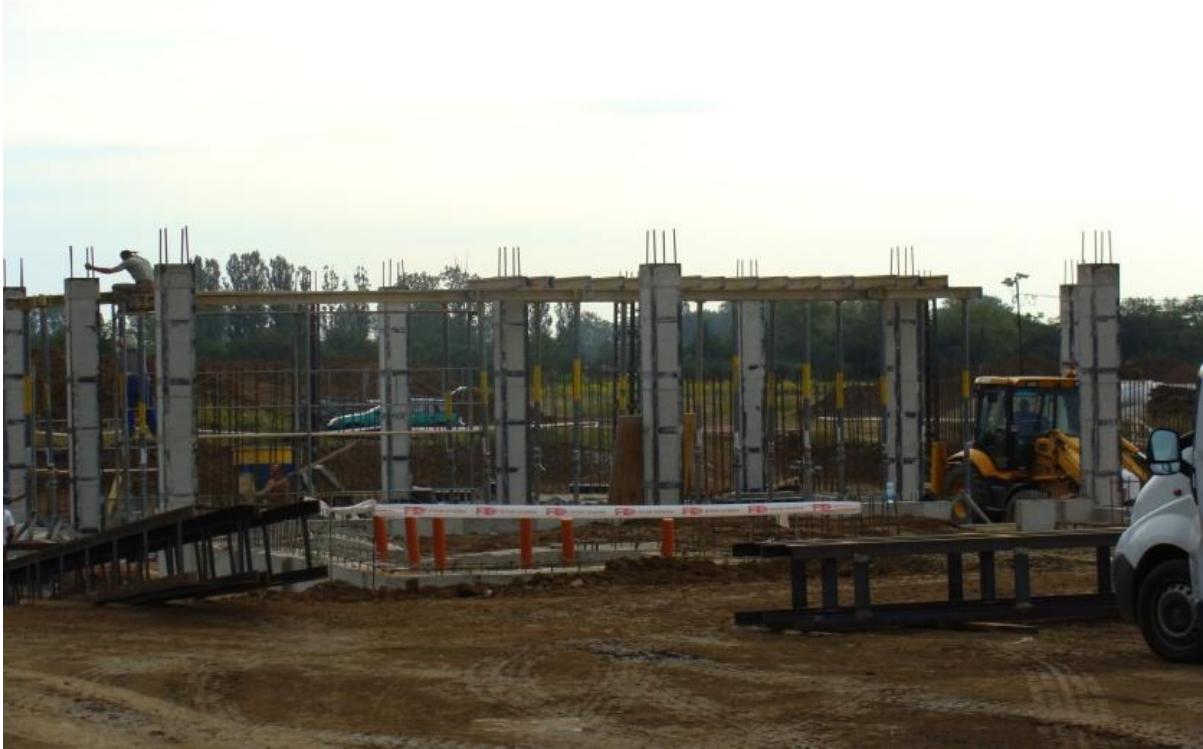
18. ábra: Hőközpont építése
