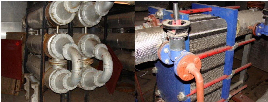
21. ábra: Csőszerelvényes és lemezes hőcserélő
