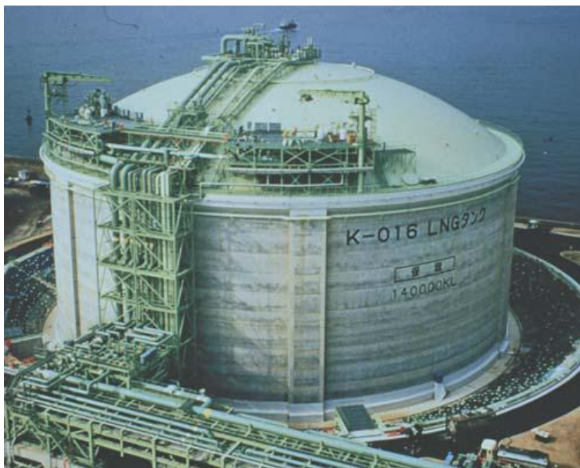
8. ábra: Szabadtéri feszített betontartály, Osaka, Japán (beton nyomószilárdsága: f_{cw}=60 \text{ N/mm}^2 )
