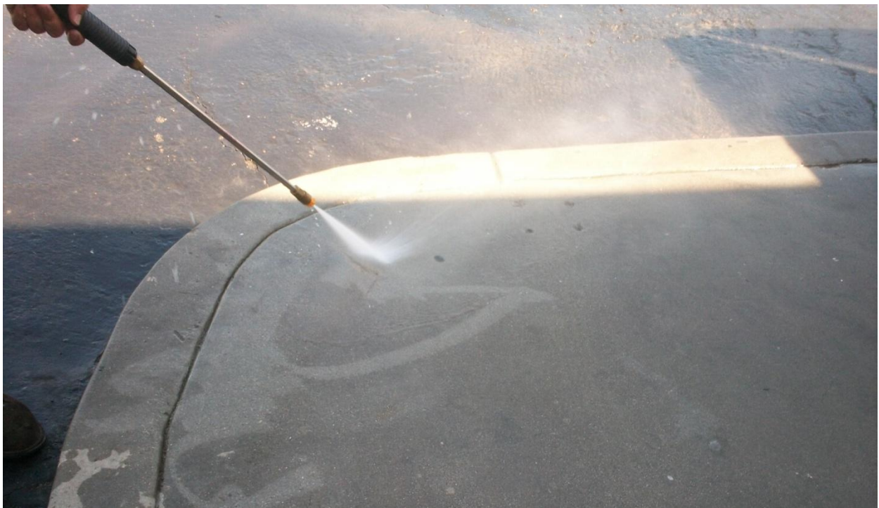
14. ábra: A beton tisztítása vízszugárral [6.]
