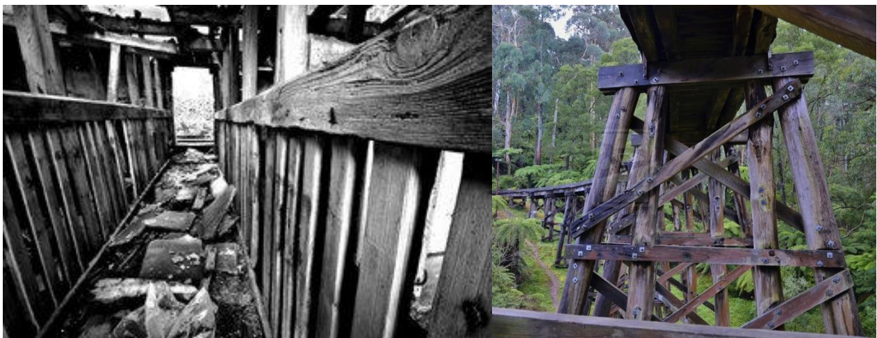
8-9. ábra: Példák a fa károsodására [7.]
