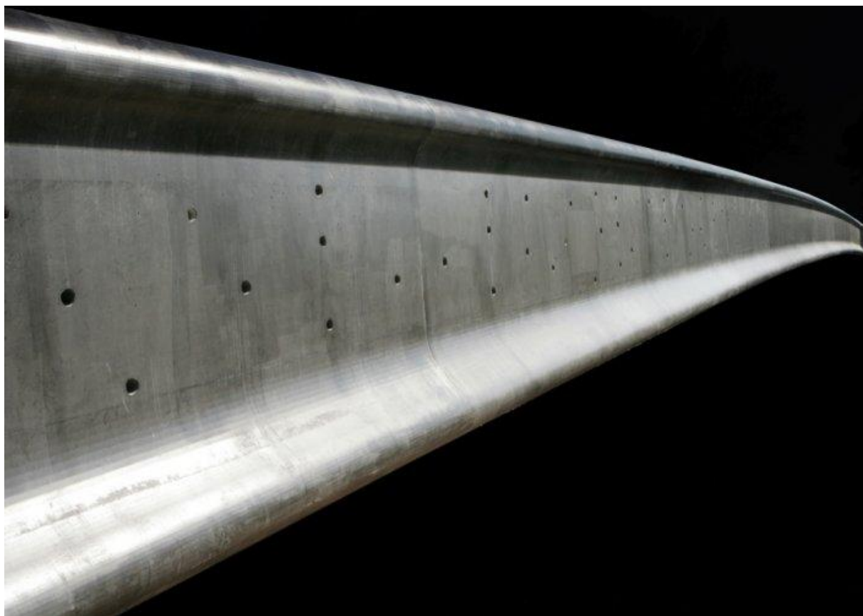
5. ábra: Pont du Diale - R. Riciotti - a szálerősített betonból készült híd [5.]
