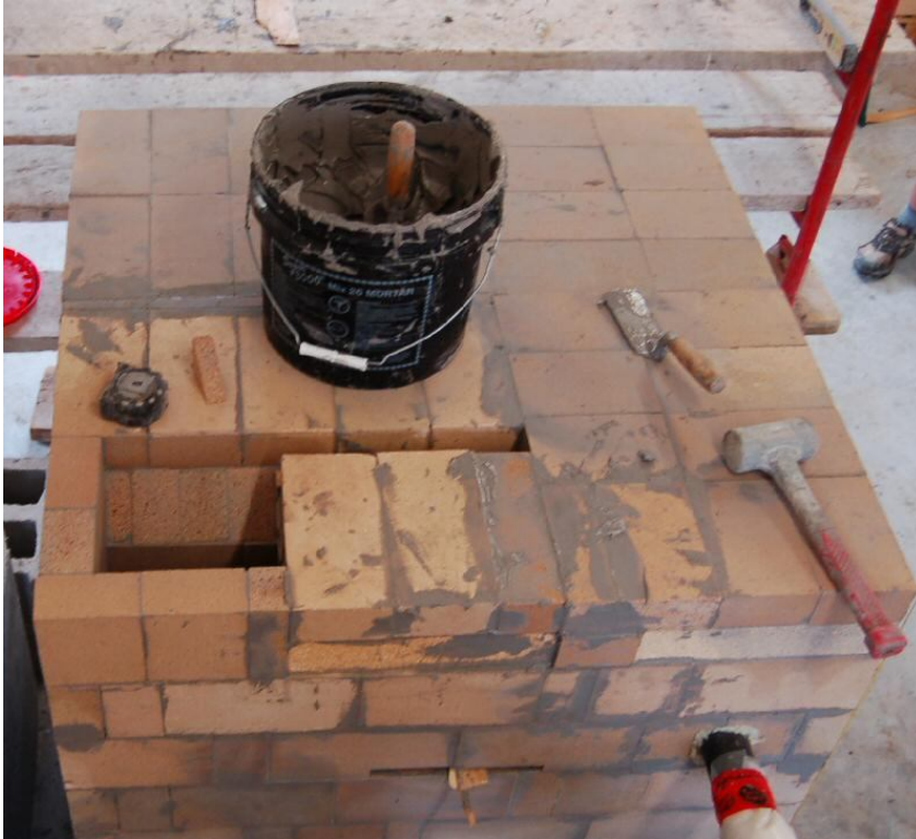
26. kép A téglakályha füstkivezetésének kialakítása
