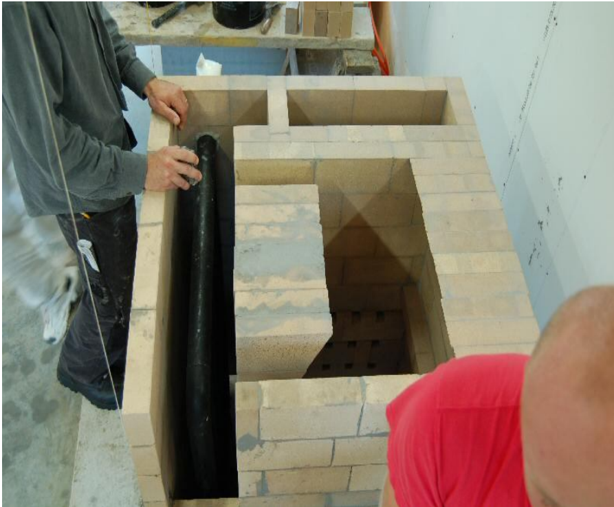
24. kép A téglakályha záró lefedése előtt
