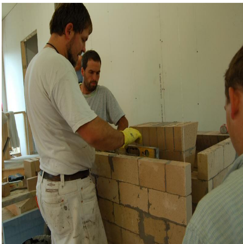
21.kép A csőregiszter vízszintezővel történő beállítása a buborék kialakulása elkerülése érdekében
