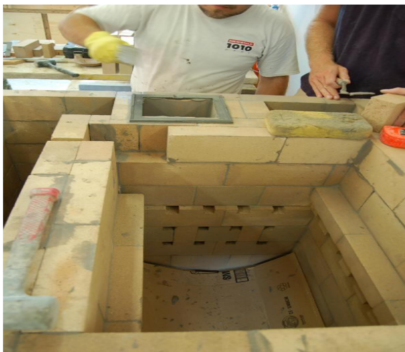
18. kép Az előmelegítést szolgáló nyitó- záró szerkezet megépítése
