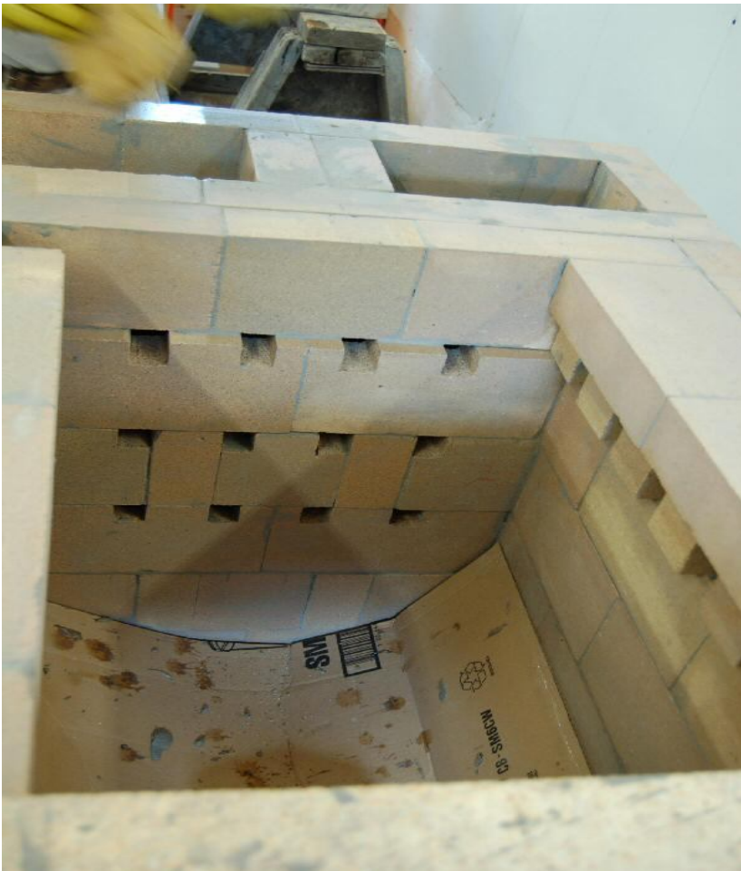
17. kép Részlet a tűztér belső légáramlat rendszeréről
