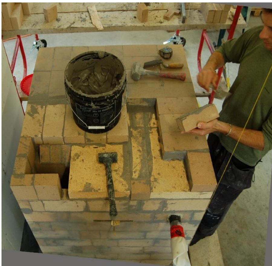
25. kép A téglakályha záró lefedése
