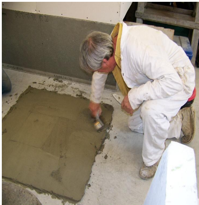
4. kép Alap készítése
