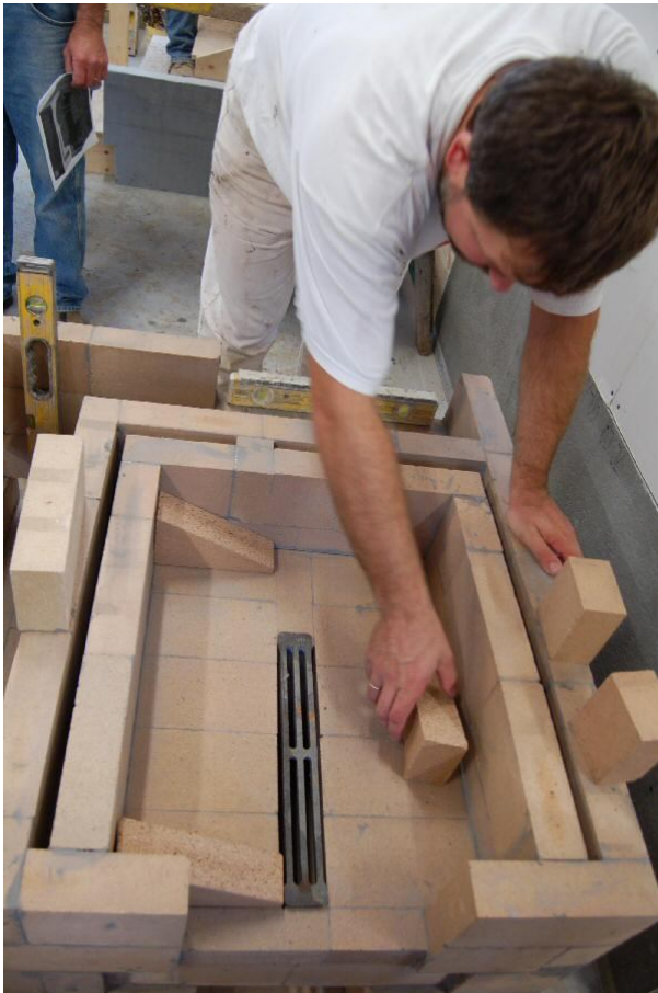
12. kép Tűztér kialakításának kezdete Látható az ék alakú samott téglák elhelyezésének kialakítása
