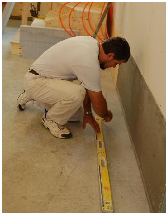
3. kép Kijelölése a téglakályha helyének
