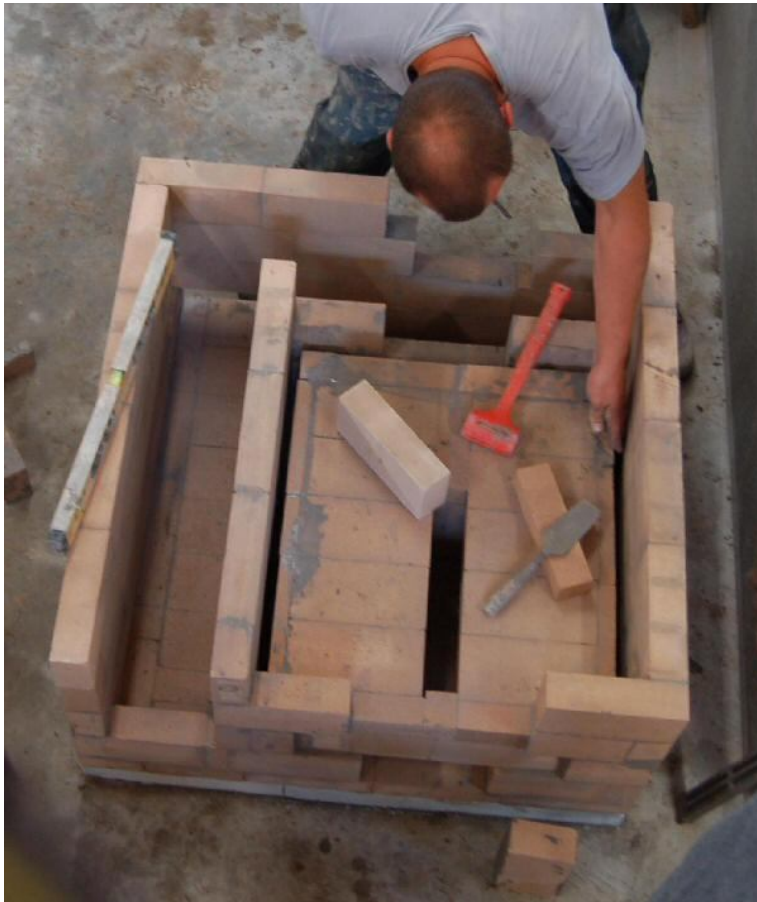
10. kép Második harang (kamra) kialakítása
