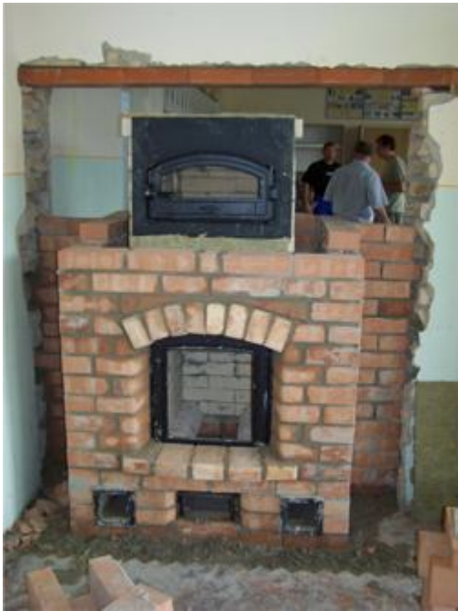
1 kép: A külső héjazat falazása.
