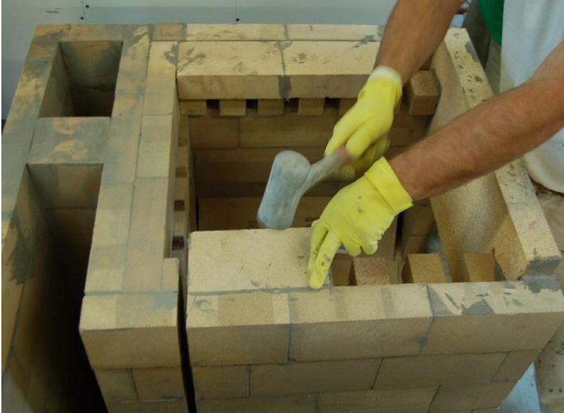
16.kép Baloldali belső sarokban a függőleges nyílás a csőregiszter felé
