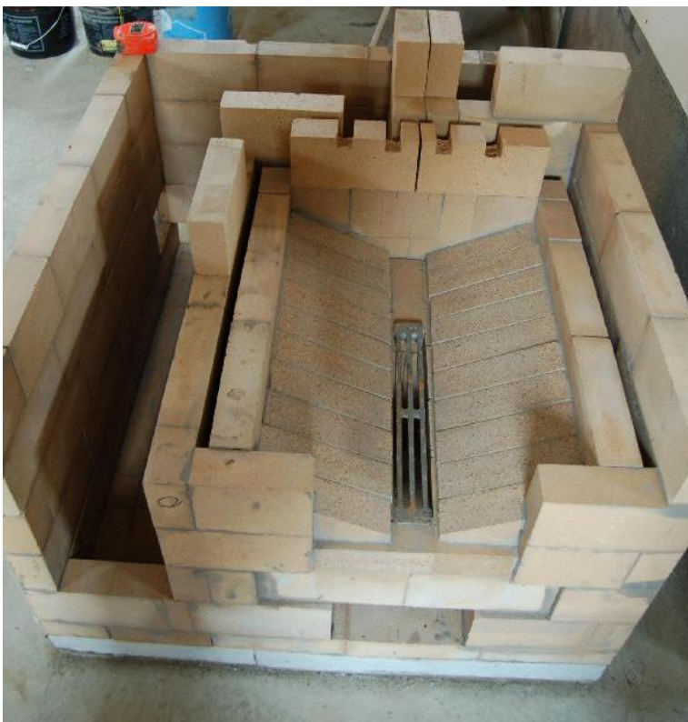
13. kép Tűztér kialakítása
