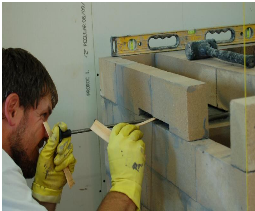
20. kép Előmelegítő nyitó-záró szerkezet behelyezése
