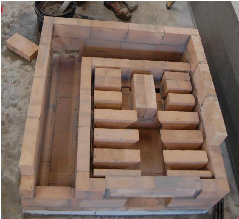
8. kép Szekunder levegő vezetése oldal irányokba
