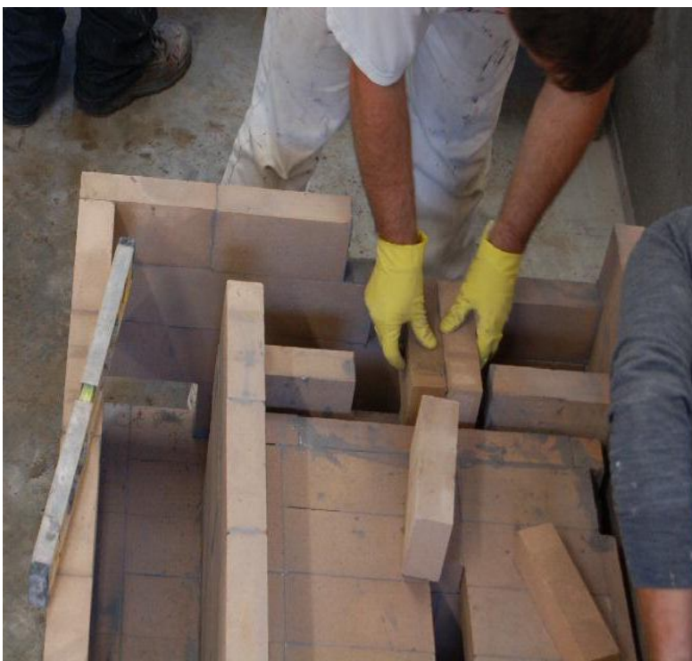
11. kép A második kamra hátsó kialakítása
