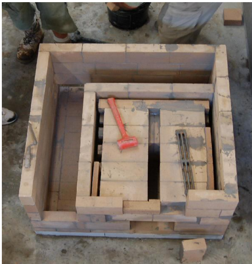
9.kép Hamutér lefedése
