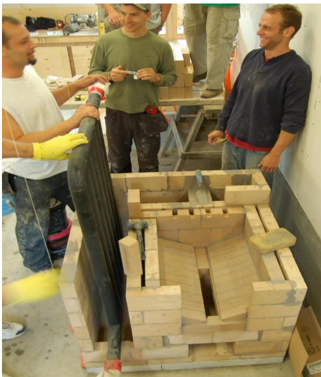
14. kép A csőregiszter beállításának próbája
