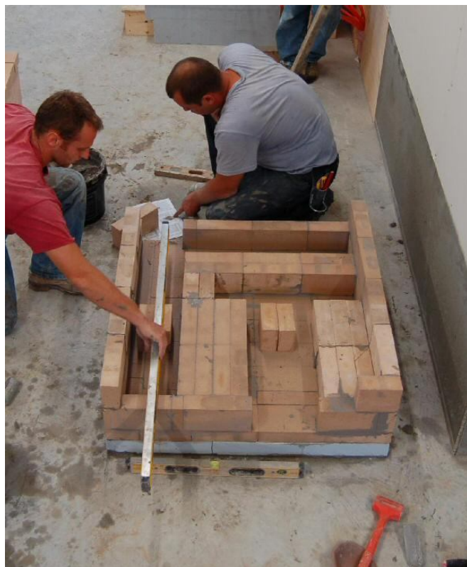
5. kép A hamutér és a csőregiszter helyének kialakítása
