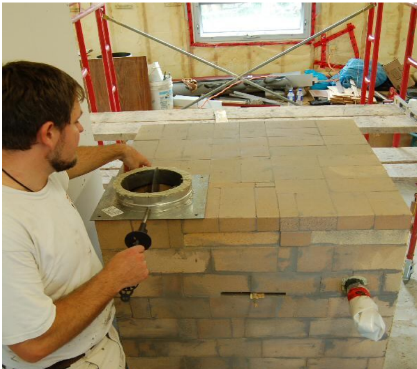
27.kép A füstcső előtt illeszkedő elzáró szerkezet felhelyezése
