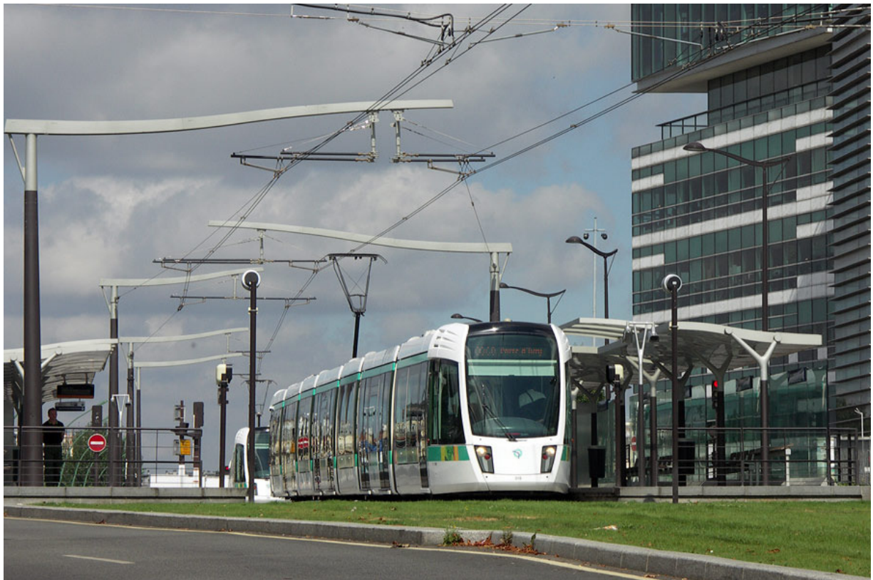
1. ábra Alstom Citadis közúti vasút, fűvesített pályán Párizsban
