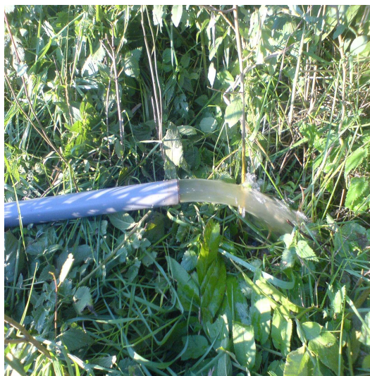
6. ábra Szürke szennyvíz kivezetése
