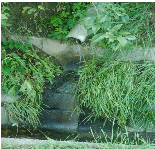
4. ábra Szürke szennyvíz bevezetés a patakba
