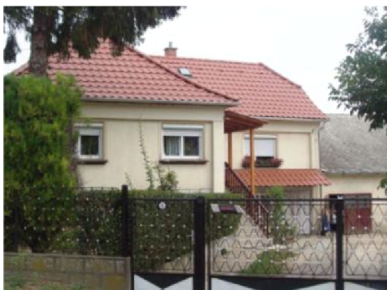
52. fotó: Aláfejtett, vasbetonkoszorúval megerősített, gazdasági épületekkel kiegészített kockaház Dudaron. Legeza Borbála felvétele, 2012.
