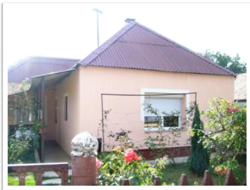
44. fotó: Vasbetonnal megerősített, átalakított FAKSZ-ház Dudaron napjainkban.
