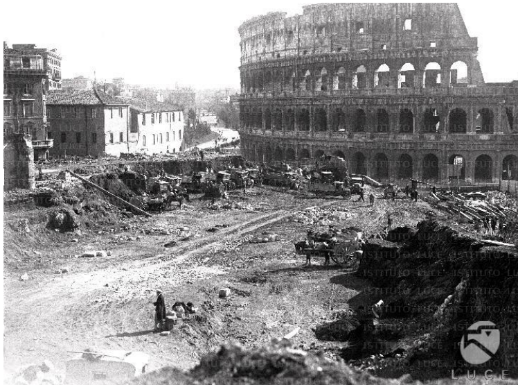
8. A Via dei Fori Imperiali építése a Colosseumra nézve. Forrás: (Mediateca Roma, 1932b)
