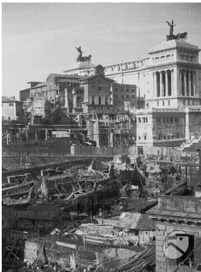
9. A Via dei Fori Imperiali építése a II. Viktor Emánuel emlékműre nézve. Forrás: (Mediateca Roma, 1932a)
