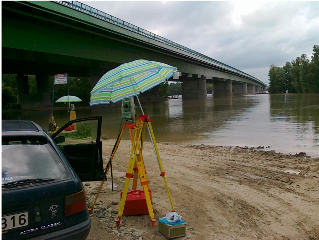
3-1 Leica TPS 1201 típusú robot mérőállomások mérés közben
