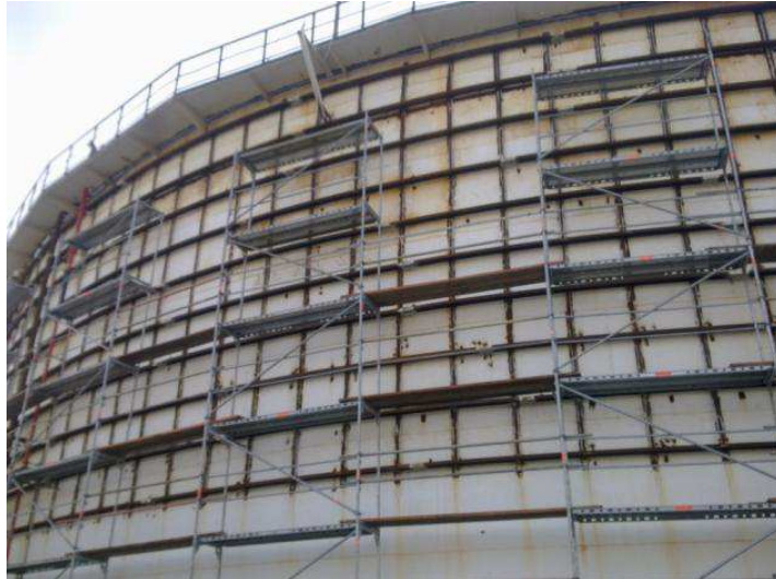
4. ábra: Tartály falának újrabordázása
