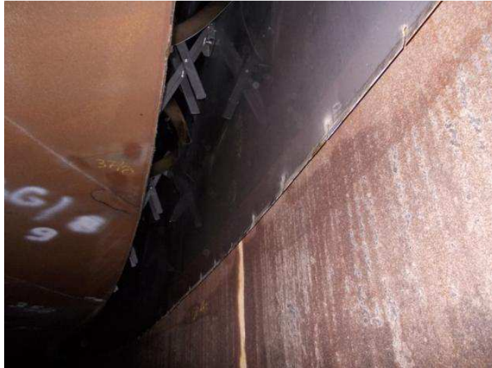
5. ábra: Úszótető és a tartály falának kapcsolata
