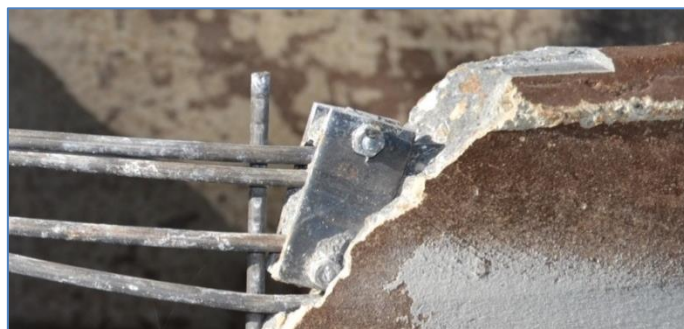
2.7. ábra: Sentab cső spirálisan futó feszítőhuzal végének rögzítő eleme (Kép készült: 2013. 10. 08.)
