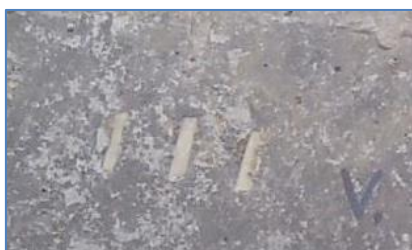
6.6. ábra: Feszítőhuzal távtartója a beton felületén (Kép készült: 2012. 07. 16.)
