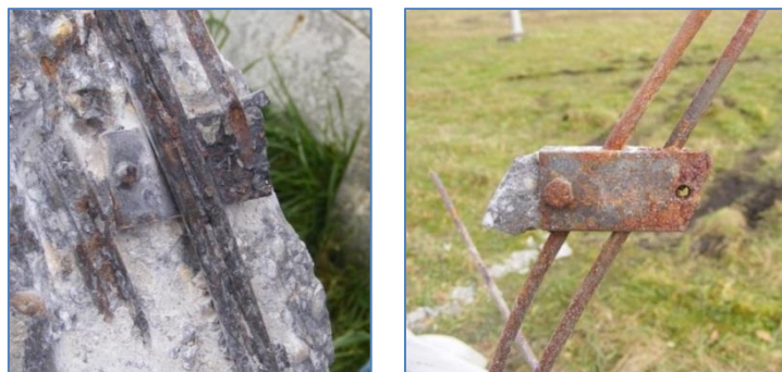
6.22. ábra: Spirálisan futó feszítőbetét véglehorgonyzása (Képek készültek: 2010. 11. 04.)
