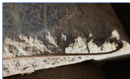
6.11. ábra: Munkagödör kiemeléskor megsértett betonfedés (A képek két különböző munkagödörben készültek 2013. 05. 06-án)
