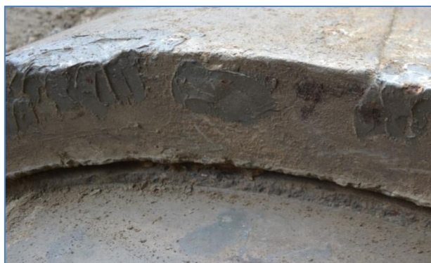
6.13. ábra: Cső бүтүс felületének és tokvég palástjának javítása (Kép készült: 2012. 06. 12.)
