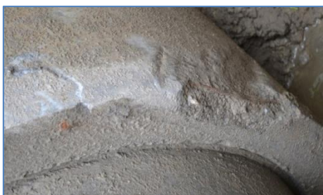
6.11. ábra: Munkagödör kiemeléskor megsértett betonfedés (A képek két különböző munkagödörben készültek 2013. 05. 06-án)
