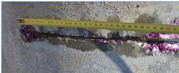
6.17. ábra: Karbonátosodási front elérte a feszítőhuzalt (Kép készült: 2013. 07. 22.)
