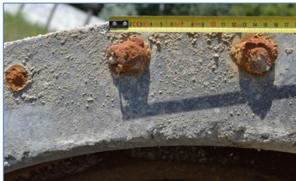
6.1. ábra: Sentab cső bütös felületén észlelt rozsdafoltok (Kép készült: 2013. 07. 17.)
