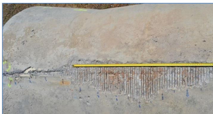
6.21. ábra: I. számú cső zsaluillesztésénél észlelt hibahely feltárása (Képek készültek: 2013. 07. 18.)
