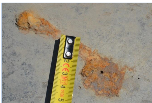
6.9. ábra: Beton felületén észlelt rozsdafolt a rozsdatermék eltávolítását követően, kép készültek: 2013. 07. 17.)
