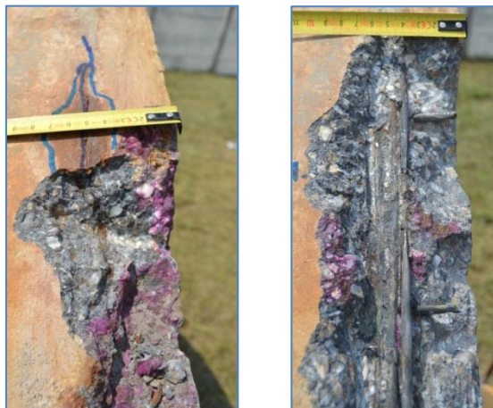
6.26. ábra: Rozsdatermék alatt talált repedés környezetének feltárása (Képek készültek: 2013. 07. 18.)
