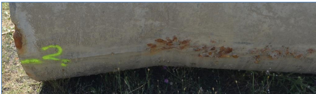
6.3. ábra: Zsaluillesztésnél észlelt rozsdafolt üzemen kívüli csövön (Kép készült: 2013. 07. 17.)
