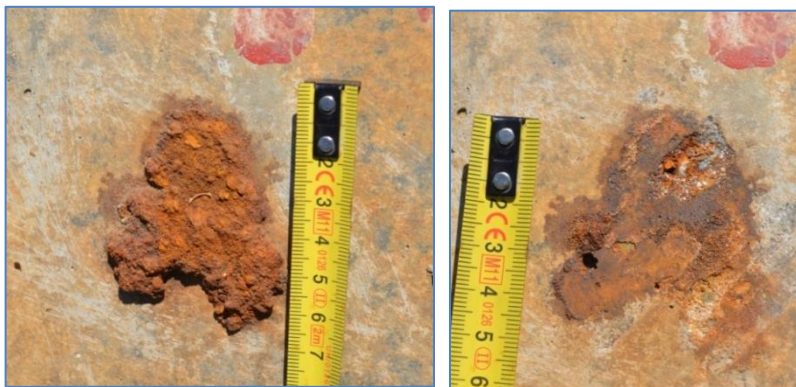
6.8. ábra: Beton felületén észlelt, hozzávetőlegesen 5×4 cm kiterjedésű rozsdafolt a felmérés kezdetén és a rozsdatermék eltávolítását követően, képek készültek: 2013. 07. 17.)
