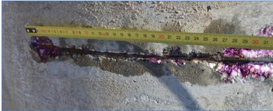
3.10. ábra: Karbonátosodási front elérte a feszítőhuzalt (Kép készült: 2013. 07. 22.)
