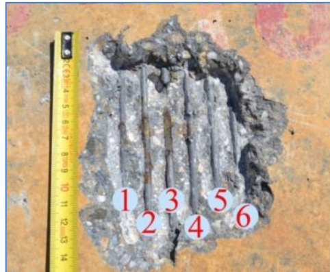
M.27. ábra: Hozzávetőlegesen 4×5 cm kiterjedésű rozsdafolt feltárása (Kép készült: 2013. 07. 22.)
