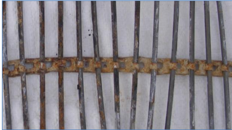
M.5. ábra: Az egyik helyszíni vizsgálatom során feltárt spirálhuzal-rendező lécz (Kép készült: 2010. 11. 04.)
