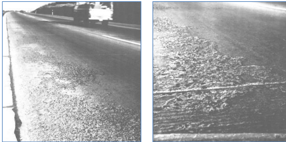
4.9. ábra: M7 autópálya beton burkolatának hámlása [Balázs - Tóth, 1998]
