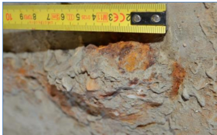
M.16. ábra: Zsaluillesztésnél észlelt talajjal keveredett rozsdatermék (Kép készült: 2013. 07. 17.)
