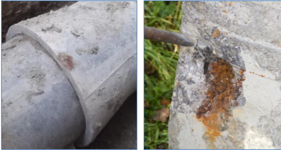
M.17. ábra: Spirálisan futó feszítőbetét véglehorgonyzásának hibája (Bal oldali kép készült: 2012. 07. 02., jobb oldali kép készült: 2010. 11. 04.)
