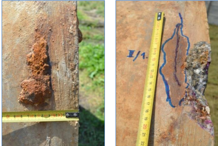
M.21. ábra: A tok végének közelében megfigyelt rozsdafolt a szemrevételezés elején és a rozsdatermék eltávolítását követően (Képek készültek: 2013. 07. 18.)
