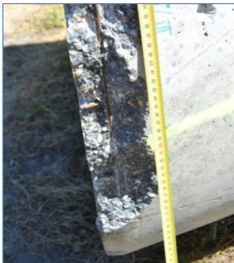
M.23. ábra: II. számú cső bütös felületénél elvégzett feltárás (Képek készültek: 2013. 07. 22.)
