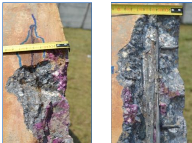
M.28. ábra: Rozsdatermék alatt talált repedés környezetének feltárása (Képek készültek: 2013. 07. 18.)
