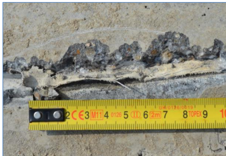
M.4. ábra: Fb-10-1200 típusú Sentab cső zsaluillesztésénél használt tömítő szalag (Kép készült: 2013. 07. 18.)
