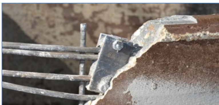
M.10. ábra: Sentab cső spirálisan futó feszítőhuzal végének rögzítő eleme (Kép készült: 2013. 10. 08.)
