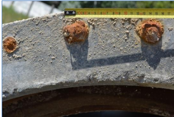
M.13. ábra: Sentab cső bütüs felületén észlelt rozsdafoltok (Kép készült: 2013. 07. 17.)
