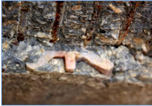
M.7. ábra: Spirális feszítőhuzal pozicionálásához használt műanyag távtartó (Kép készült: 2012. 07. 06.)
