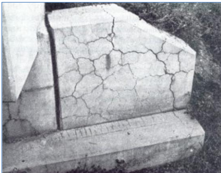
2.6. ábra: Alkáli-adalék reakció megjelenése a betonfelületen [Woods, 1968]
