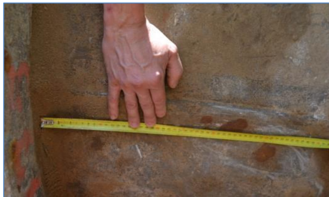
M.14. ábra: Zsaluillesztésnél észlelt rozsdafolt üzem alatti csövön (Kép készült: 2013. 04. 25.)
