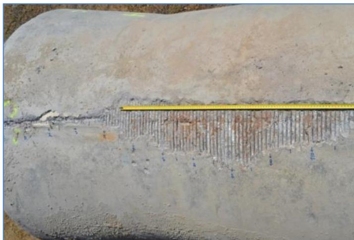
M.24. ábra: I. számú cső zsaluillesztésénél észlelt hibahely feltárása (Kép készült: 2013. 07. 18.)
