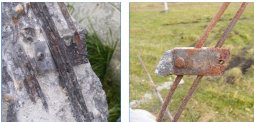
M.25. ábra: Spirálisan futó feszítőbetét véglehorgonyzása (Képek készültek: 2010. 11. 04.)
