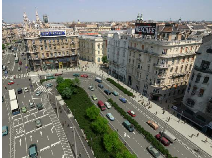
23. ábra: Az Erzsébet híd rakparti bekötése / Connection of Sissy Bridge and the Embankment
