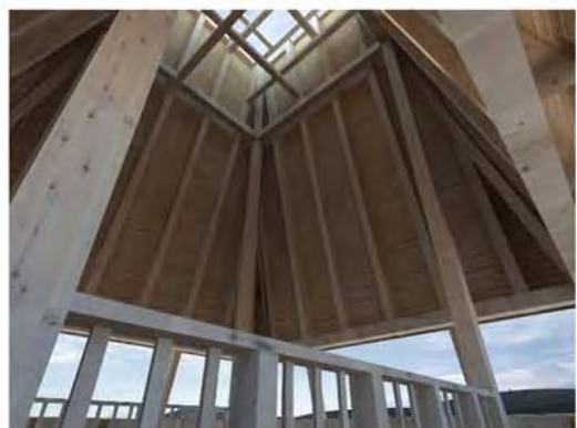
Szaruzat, deszkázat, zsindelyborítás
