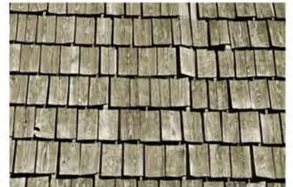
hagyományos deszka és zsindelyfedés, ácsszerkezetek
