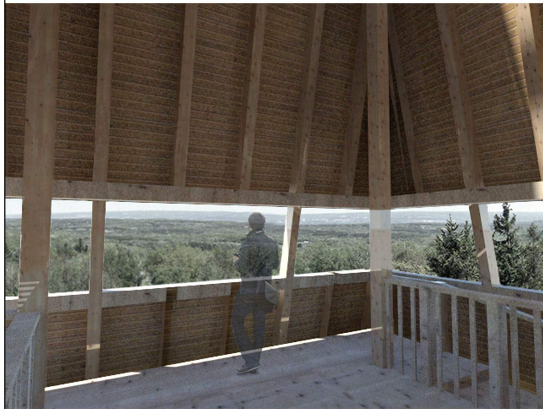
SZÉKOSZLOPOKKAL GYÁMOLÍTOTT SZELEMEN-KERETEK
