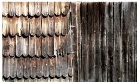
hagyományos deszka és zsindelyfedés, ácsszerkezetek
