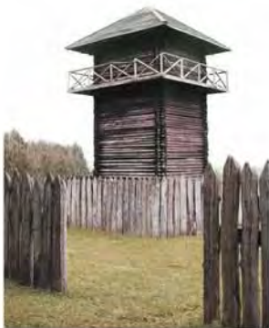
fából épült római őrtorony
