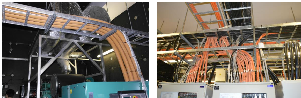
6.7. ábra: Nagy átmérőjű elektromos kábelek elhelyezése a kábeltálcákon (bal oldali képen a diesel aggregát, jobb oldali képen az elektromos elosztó központ, képek készültek: 2013. 05. 24.)
