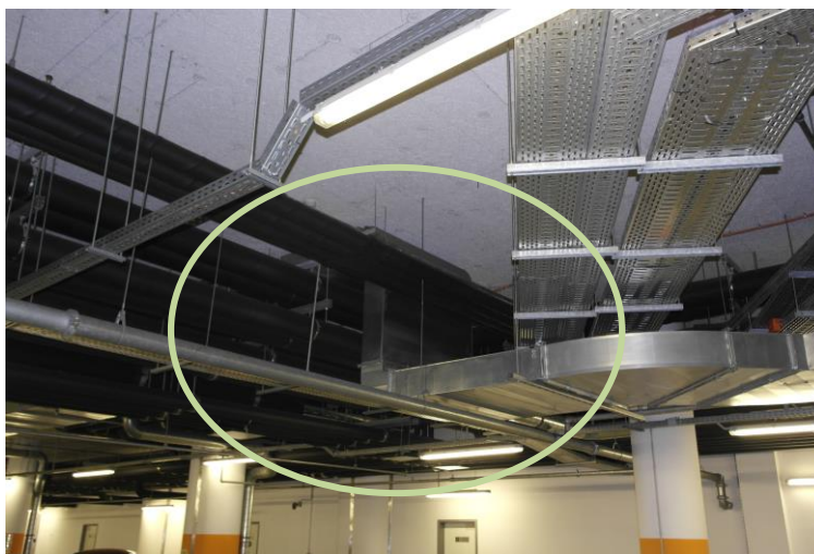
6.4. ábra: Légtechnikai csatorna iránytörése a keresztező csőkötegeknél (kép készült: 2013.
