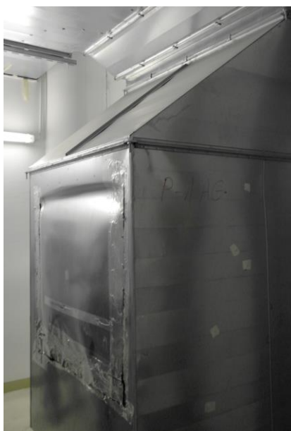
6.6. ábra: Légtechnikai berendezés utólagos átalakítása (kép készült: 2013. 05. 24.)
