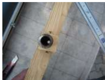
A pontszerű terhelés merevítése
