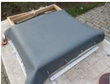
Vízszigetelés oldalsó megfogása
