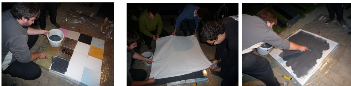
Az általunk készített egy négyzetméternyi felületű, 16 különféle hőszigetelésre felhordott bevonat szigetelés készítése.
