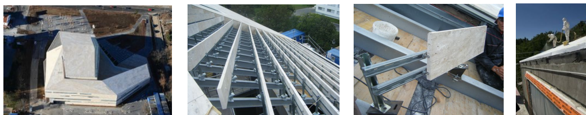
Az első három képen a pécsi Kodály Központ burkolt tetejének a kivitelezése látható a már elkészült vízszigetelés fölött. A negyedik képen Villa Hermina nyaraló külső végleges burkolatnak, a vízszigetelésnek felhordása látható.
